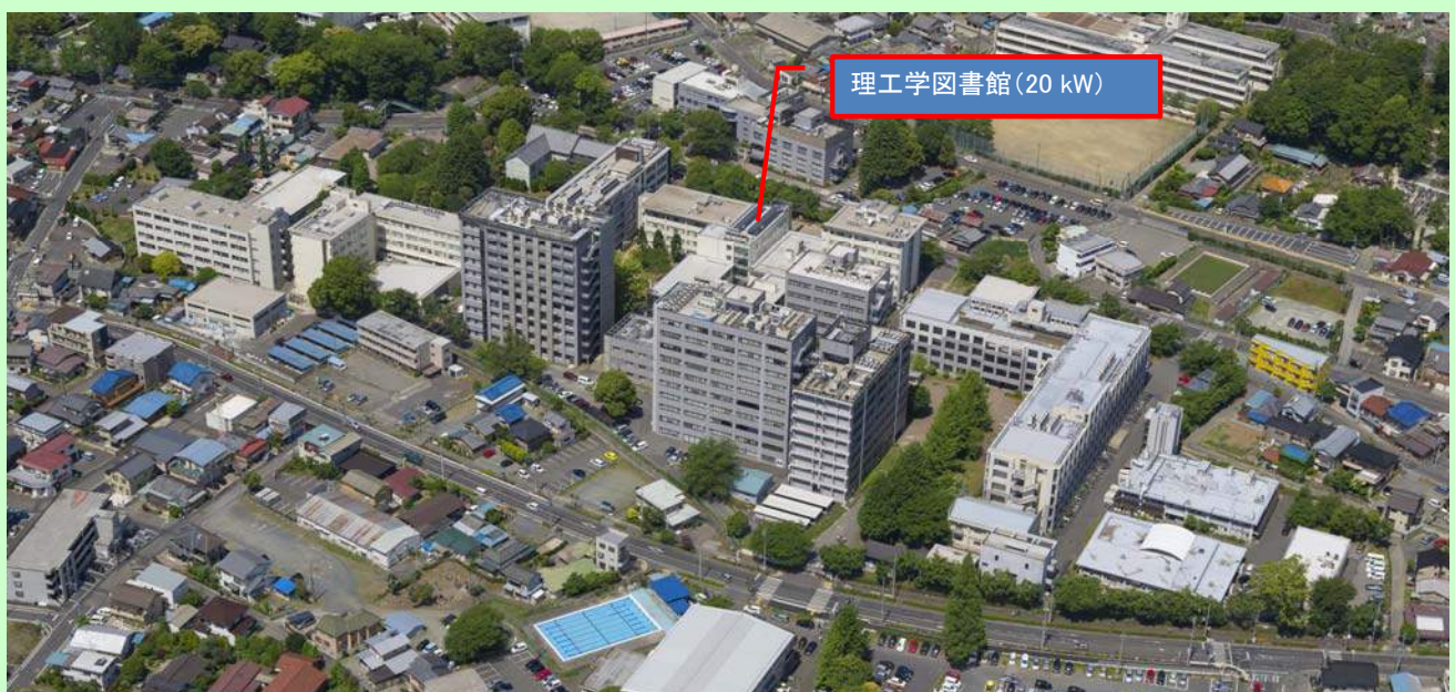
写真 2 桐生団地太陽光発電設備設置状況
