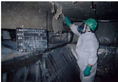
アスベスト除去状況
