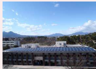
中央図書館屋上
