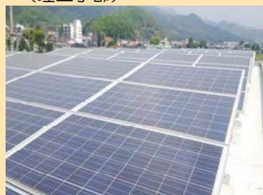
課外活動施設屋上
