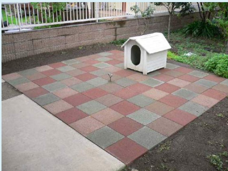
写真2 ウッドチップモルタル平板の施工例
